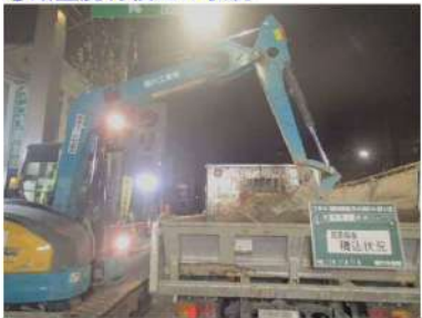
④路盤廃材積み込み状況
