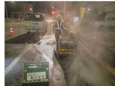
⑲仮舗装 表層工転圧状況
