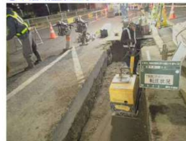
⑯下層路盤転圧状況
