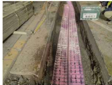
⑭埋設シート敷設完了
