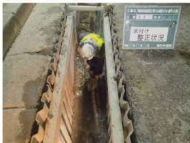
⑦床付け整正状況
