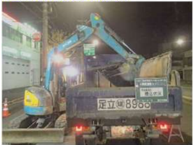
②既設舗装版積み込み状況
