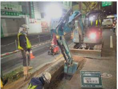
③既設路盤掘削状況
