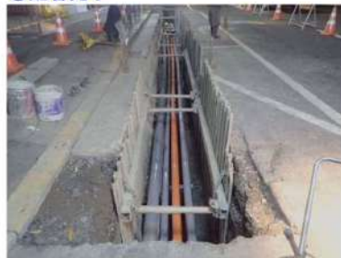
⑫配管完了
