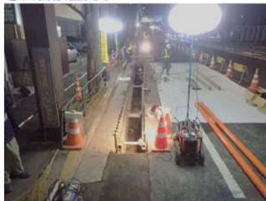
⑧山留設置完了
