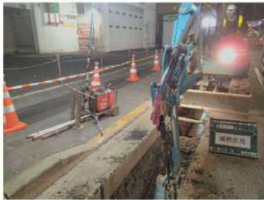
⑤掘削状況
