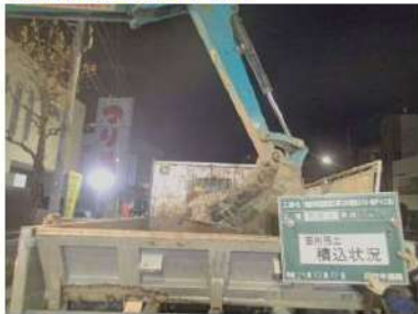
⑥掘削残土積み込み状況
