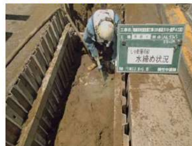
⑫遮断砂水締め状況
