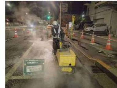
⑱仮舗装 基層工転圧状況
