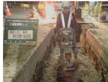
⑬発生土埋戻し転圧状況
