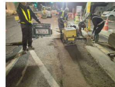
⑰上層路盤転圧状況
