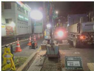
①既設舗装版取壊し状況
